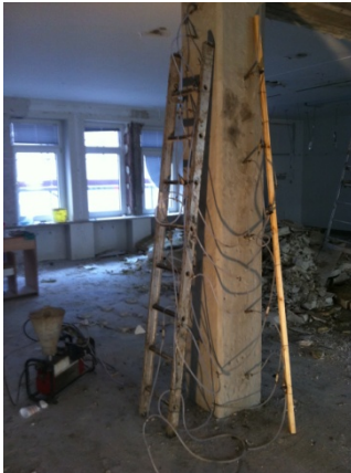
Stütze im EG. Durchführung der Niederdruck-Injektion
