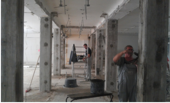
Ansicht 1. OG, fertig ertüchtigte Stützen
